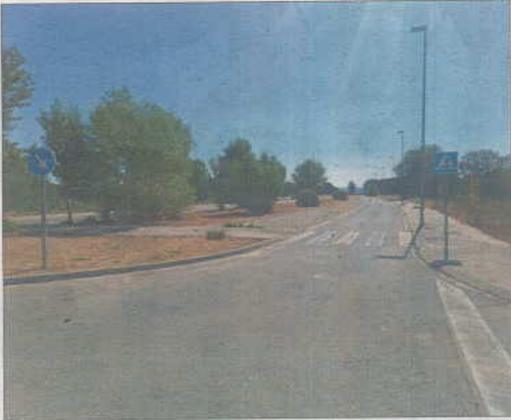
Vista del Polígono de El Brizo en Aldeamayor. E.M.
